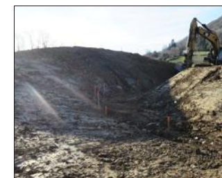
Une pelleteuse à l'œuvre sur le tracé d'un virage.
